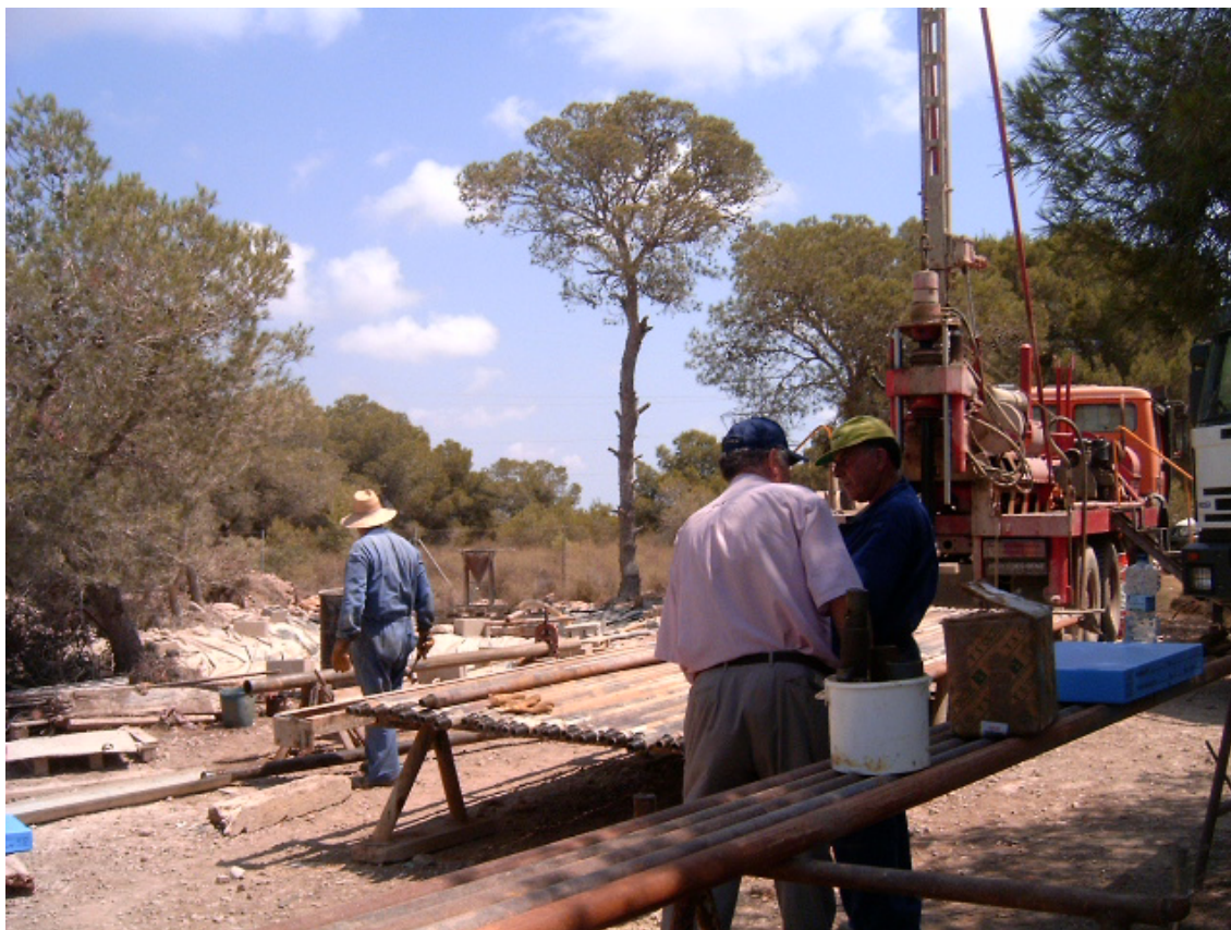
Perforación del sondeo de investigación Cabo Roig I “Depuradora”.
