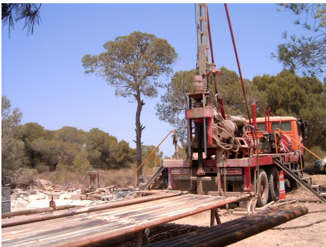
Perforación del sondeo de investigación Cabo Roig II “Polideportivo”.
